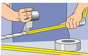
**3.** Encintado de tubería: Aplicar la cinta en forma helicoidal, solapando cada vuelta al menos un cuarto del ancho de la cinta sobre la anterior.
